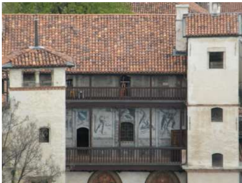
Vista del loggiato di Casa Cavassa - Fotografia di Luca Grande
